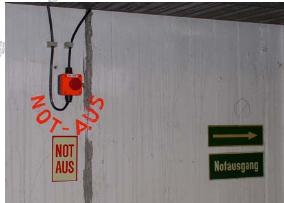
Notaus-Schalter bei DORIS und grünes Hinweisschild zum Notausgang
