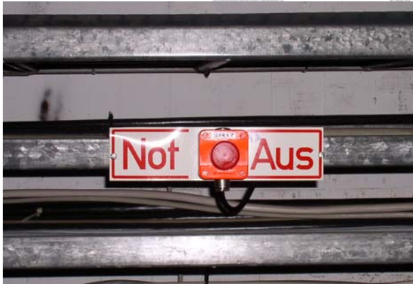
Notaus-Schalter bei DORIS und grünes Hinweisschild zum Notausgang
